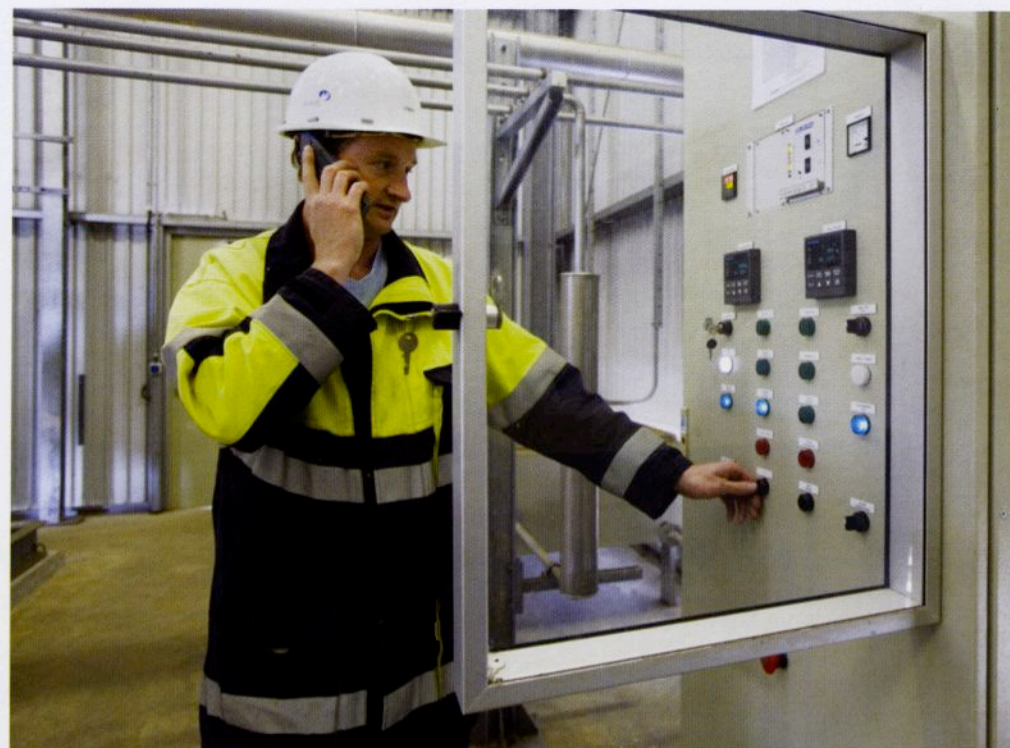
Schutzkleidung gegen Störlichtbögen wie hier bei einem Mitarbeiter des Energiekonzerns RWE ist bei allen Arbeiten an spannungsführenden Teilen vorgeschrieben.
